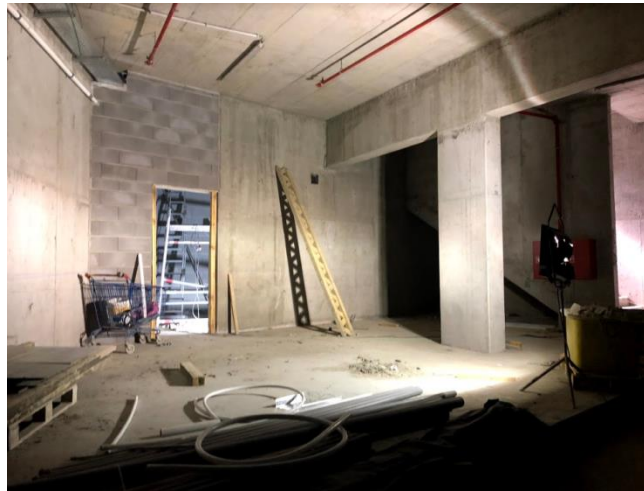
Figura 46 (obtida no local da obra a 27 de agosto de 2018): Avanços na execução da área técnica: elevação das paredes
