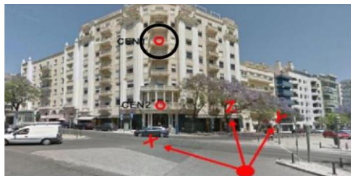
Figura 70 (adaptada de [18]): Localização dos 2 alvos topográficos no alçado do edifício envolventes ao túnel voltado para a R. Pinheiro Chagas
