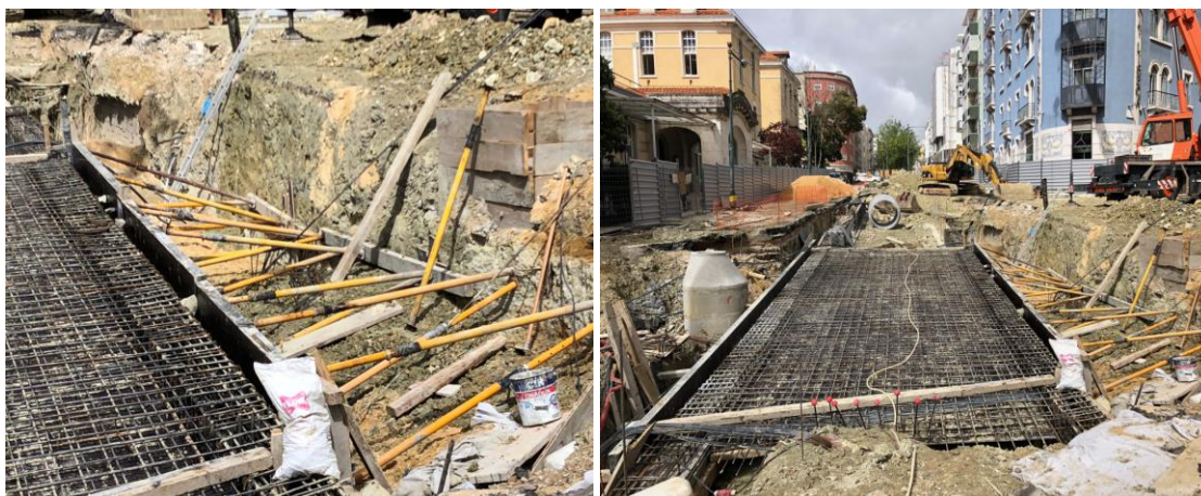
Figura 17 (obtida no local a 4 de abril de 2018): Pormenor dos escoramentos apoiados
