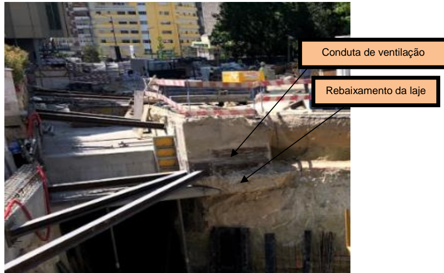
Figura 57 (obtida no local da obra a 21 de maio de 2018): Pormenor do rebaixamento da laje e da conduta de ventilação
