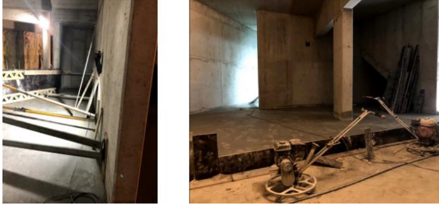
Figura 40 (obtida no local da obra a 19 de julho de 2018): Zona reservada à área técnica do túnel
