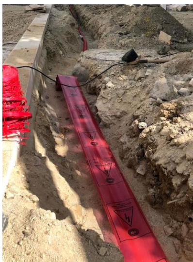
Figura 48 (obtida no local da obra a 27 de agosto de 2018): Precauções no enterro de infraestruturas
