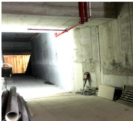
Figura 61 (obtida no local da obra a 12 de julho de 2018): Execução do piso térreo
