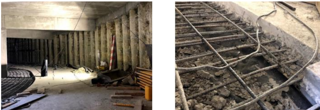
Figura 39 (obtida no local da obra a 19 de julho de 2018): Pormenores relativos à colocação das armaduras do pavimento
