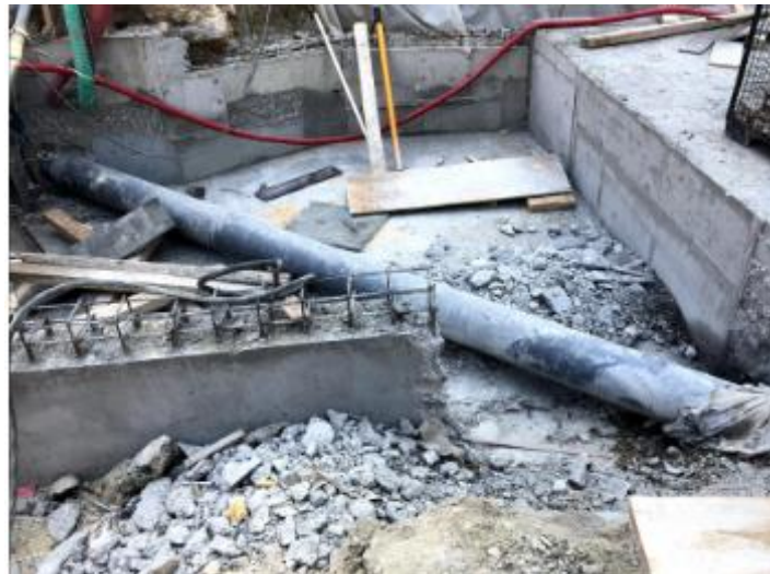
Figura 58 (obtida no local da obra a 21 de maio de 2018): Rebaixamento da laje para permitir o acesso ao tubo de esgoto da Casa Museu
