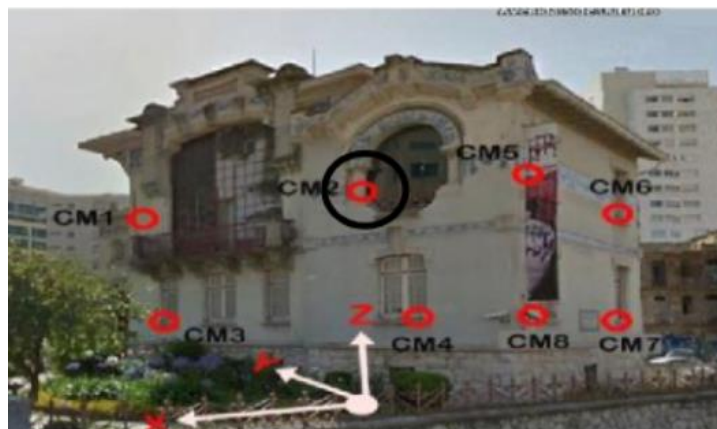
Figura 71 (adaptada de [18]): Localização dos 8 alvos topográficos no alçado do edifício da Casa Museu voltado para a Av. 5 de Outubro
