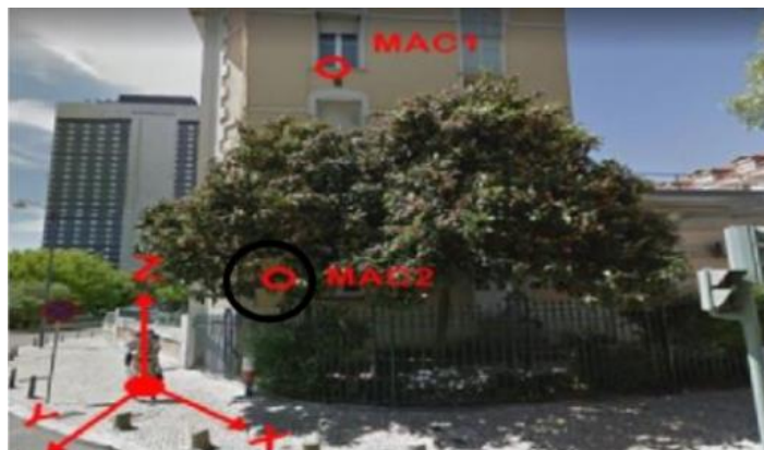
Figura 72 (adaptada de [18]): Localização dos 2 alvos topográficos no alçado do edifício da Maternidade Dr. Alfredo da Costa voltado para a R. Pinheiro Chagas
