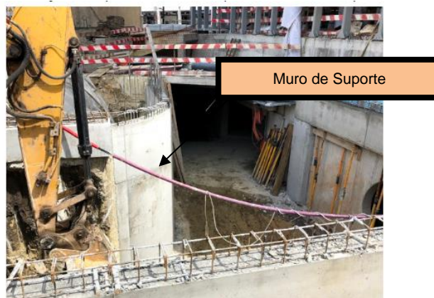
Figura 67 (obtida no local da obra a 19 de abril de 2018): Muro de suporte
