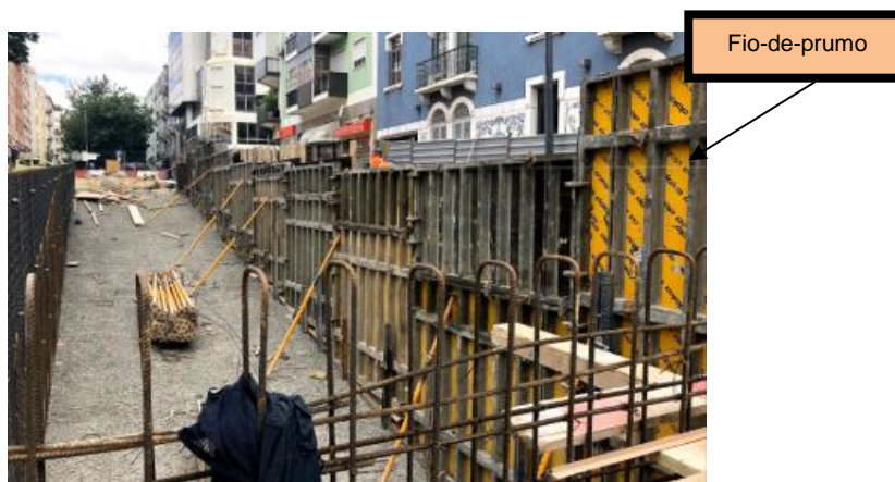
Figura 28 (obtida no local da obra a 5 de junho de 2018): Pormenor do desenvolvimento do túnel na zona inicial com especial atenção à colocação das cofragens
