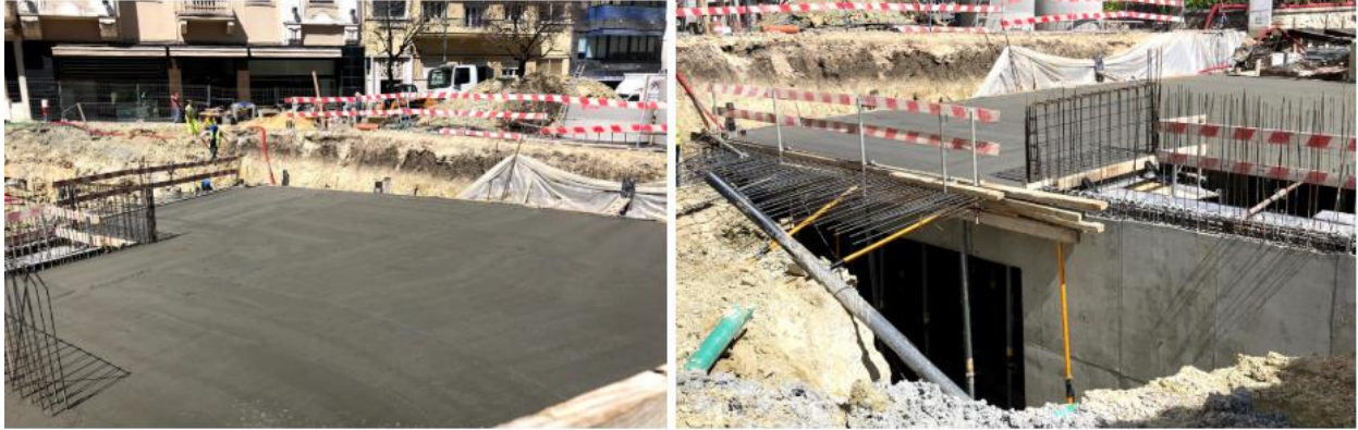
Figura 32 (obtida no local da obra a 8 de junho de 2018): Fase de cura da laje de cobertura da zona central do túnel
