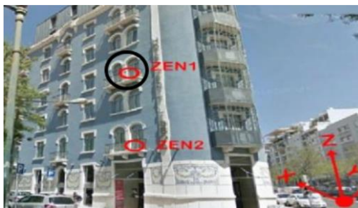
Figura 73 (adaptada de [18]): Localização dos 2 alvos topográficos no alçado do Hotel Zenit Lisboa voltado para a R. Pinheiro Chagas
