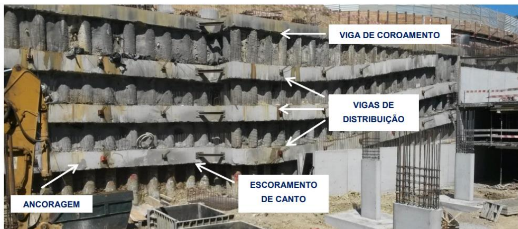
Figura 3 (retirada de [8]): Elementos constituintes da cortina
