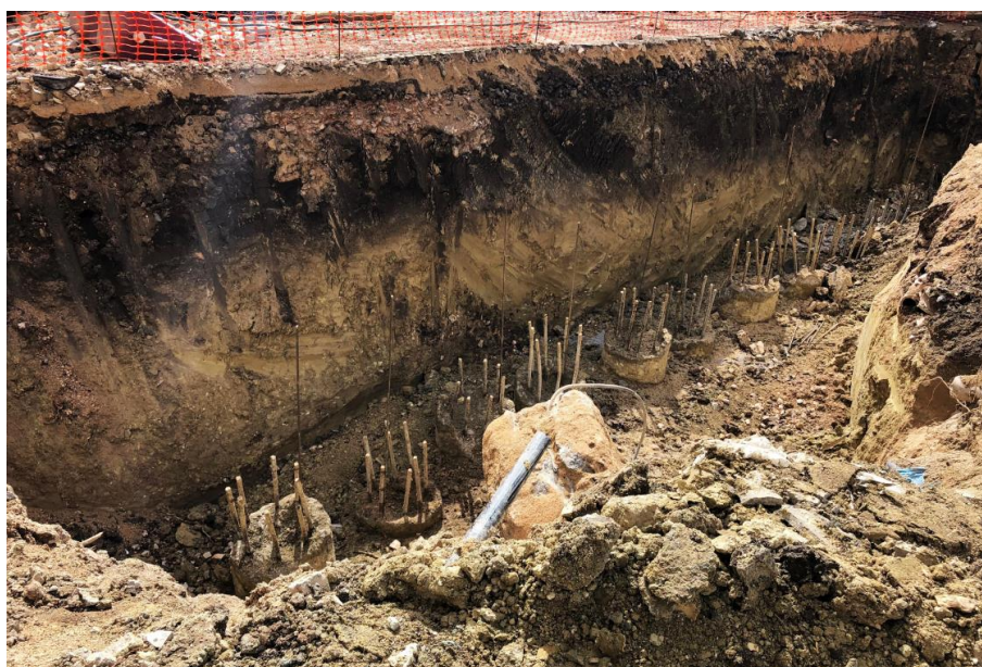
Figura 14 (obtida no local a 4 de abril de 2018): Pormenor da realização da escavação sem ser em talude
