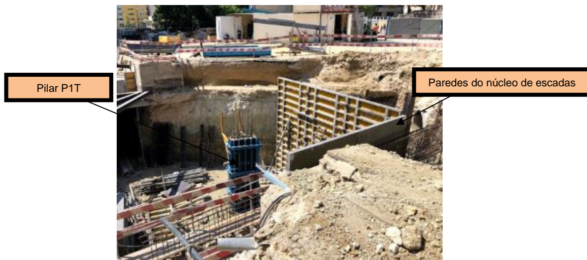
Figura 26 (obtida no local da obra a 21 de maio de 2018): Execução do pilar central P1T e das paredes do núcleo de escadas de acesso à saída de emergência
