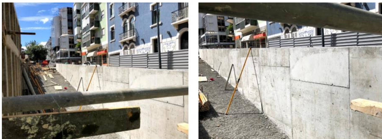
Figura 31 (obtida no local da obra a 8 de junho de 2018): Betonagem de uma das paredes do túnel no trecho junto à Maternidade Dr. Alfredo da Costa
