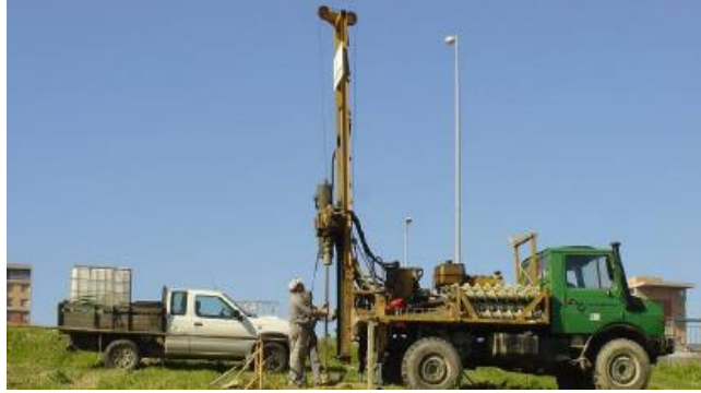
Figura 9 (retirada de [12]): Sonda Mobile Drill, utilizada na execução das sondagens
